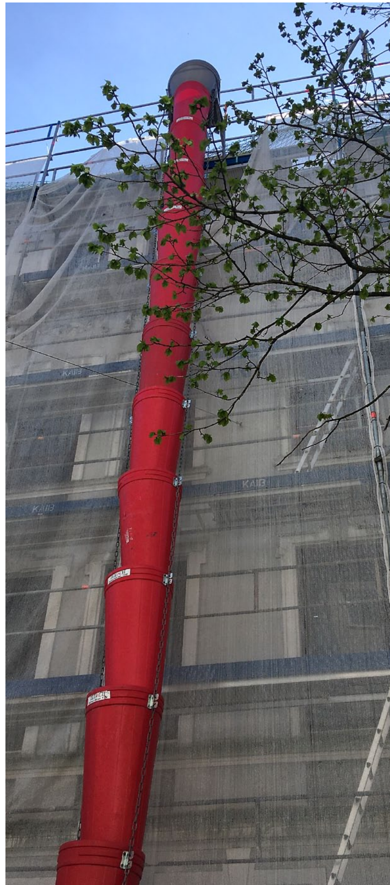
Das Engagement der STÄWOG im Bremerhavener Goethequartier geht weiter. In der Uhlandstraße 25 wird ein weiteres Gebäude entkernt und saniert.
