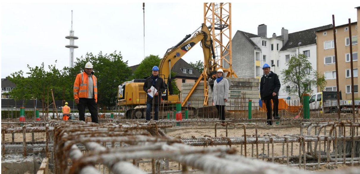
Der zweite serielle Neubau der STÄWOG feiert Baubeginn. In der Nürnberger Straße entsteht ein Mehrfamilienhaus und eine Kinderkrippe auf einem ehemaligen Parkplatz.
