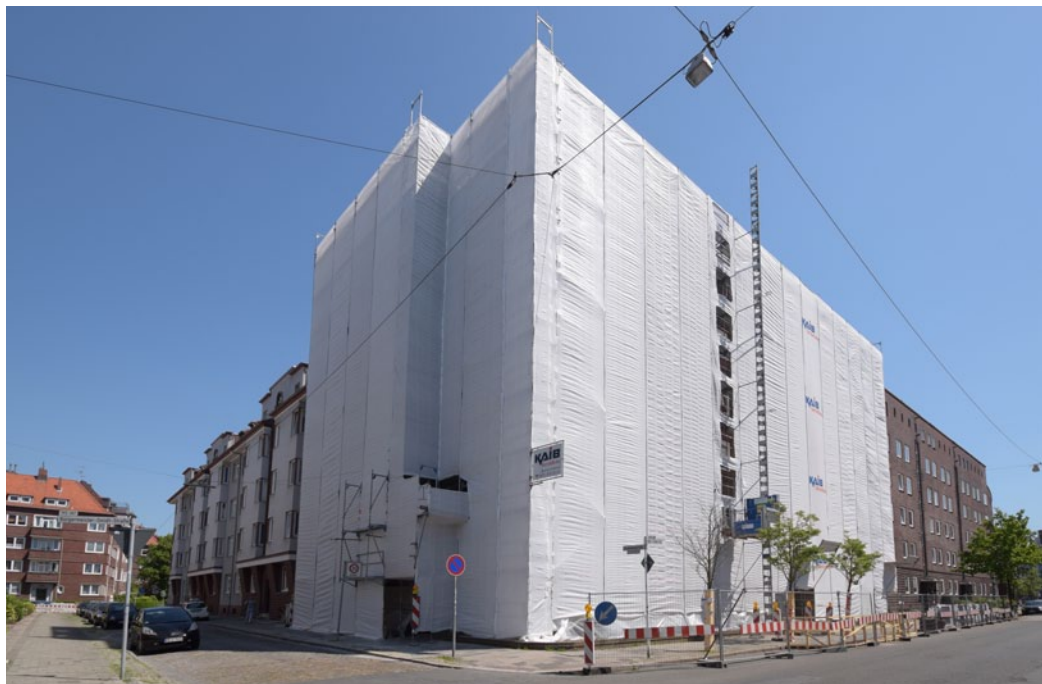
Wieder gut verpackt: Die Fassade musste leider erneut zum Schutz vor Feuchtigkeitsschäden mit einer Plane geschützt werden.
