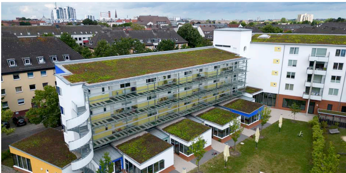
Das größte Gründach in Bremerhaven ist zurzeit in der Nürnberger Straße zu finden.
