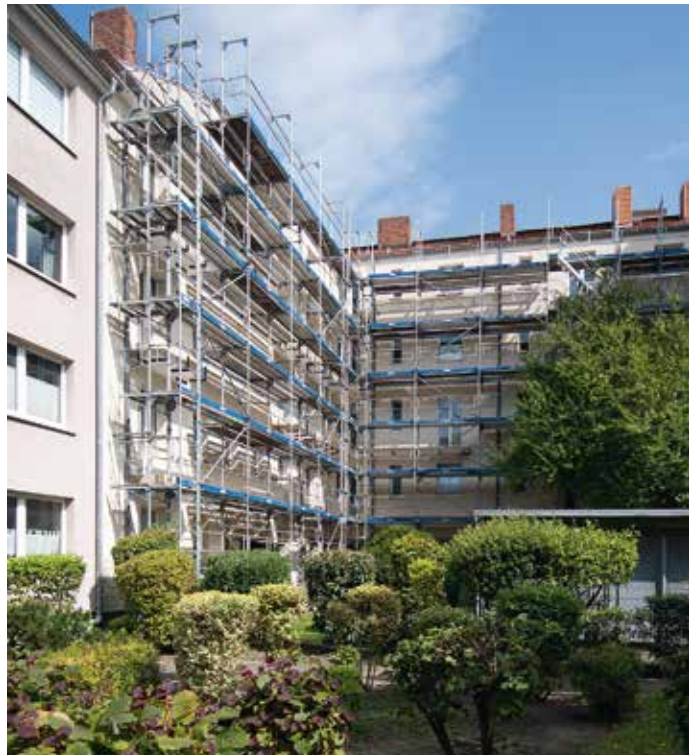
Sonnenstraße 3 und 5: Sanierung der Fassade im Innenhof
