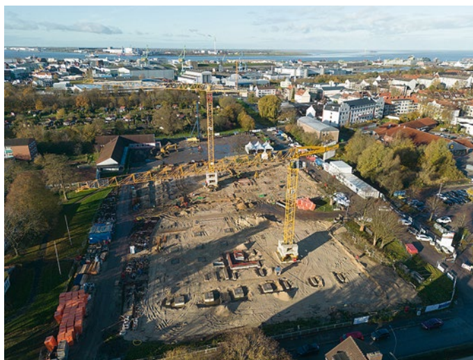
Blick auf die Baustelle für das Schulzentrum Hamburger Straße
