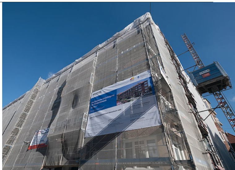
Sanierungsarbeiten an der Wohnanlage Scharnhorststraße 11-15
