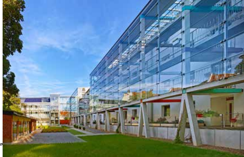
Die schrägen Betonstützen der Wohnwege erinnern im Erdgeschoss an einen christlichen Kreuzgang, und in der Tat umschließt die Anlage wie in einem Kloster einen ruhigen Hof.
