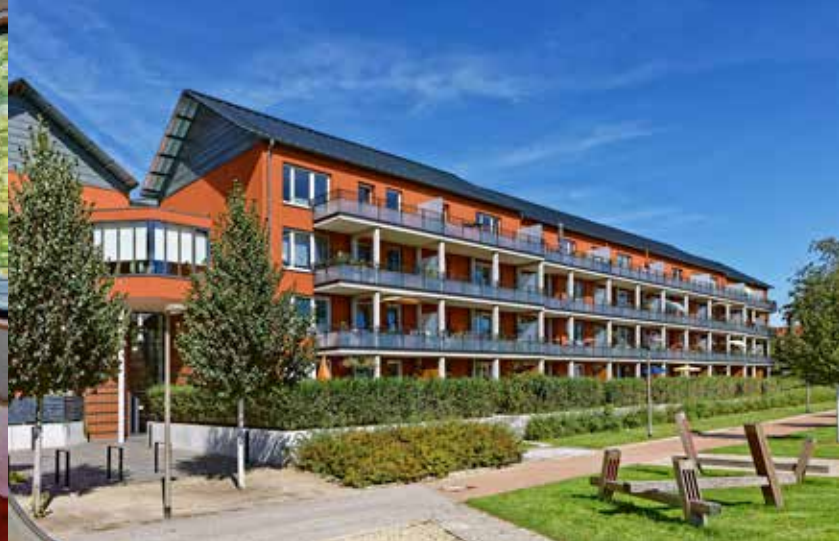
Die Südseite erhielt großzügige Balkone und im Erdgeschoss Mietergärten (hinter den Hecken). Man sieht in der linken Bildmitte den »Zwischenraum«.
