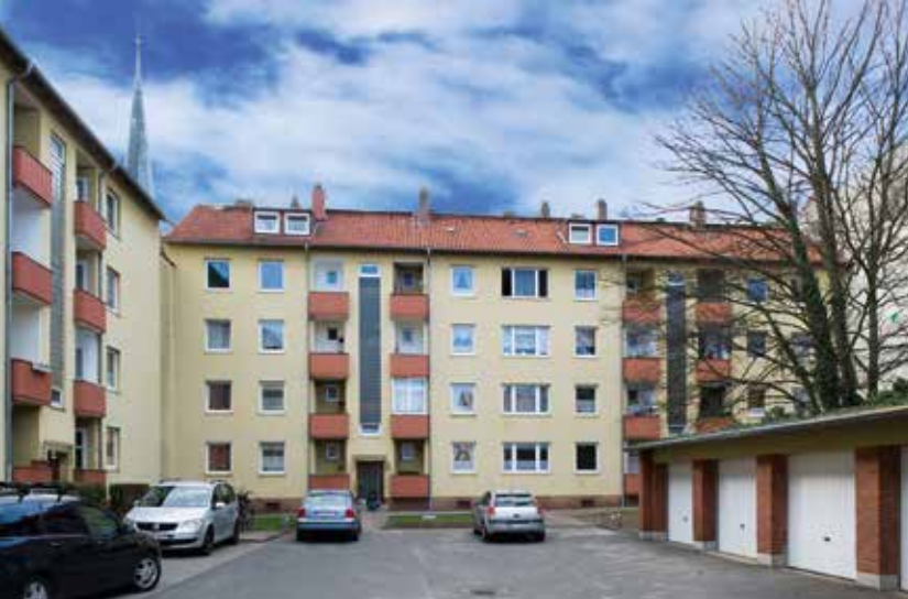
Der Hof als asphaltierte Restfläche und als Parkplatz mit Garagen, so war es früher. An den Hoffassaden gab es winzige Küchenbalkone, die den Mietern wenig nutzten.
